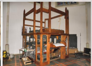
Aufbau des Außengehäuses
