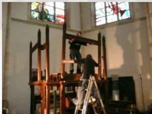
Aufbau des Außengehäuses
