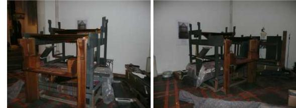
Fr./Sa. 24.+25.02. Einbau der Pedallade und Aufbau des Gehäuses
